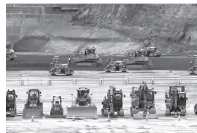
▲重機による転圧ローラ作業（筆者撮影）
