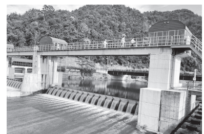
▲成瀬頭首工全景(筆者撮影)
