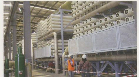
日本がトップレベルの技術力を誇る海水淡水化装置。(写真/吉村和就)
