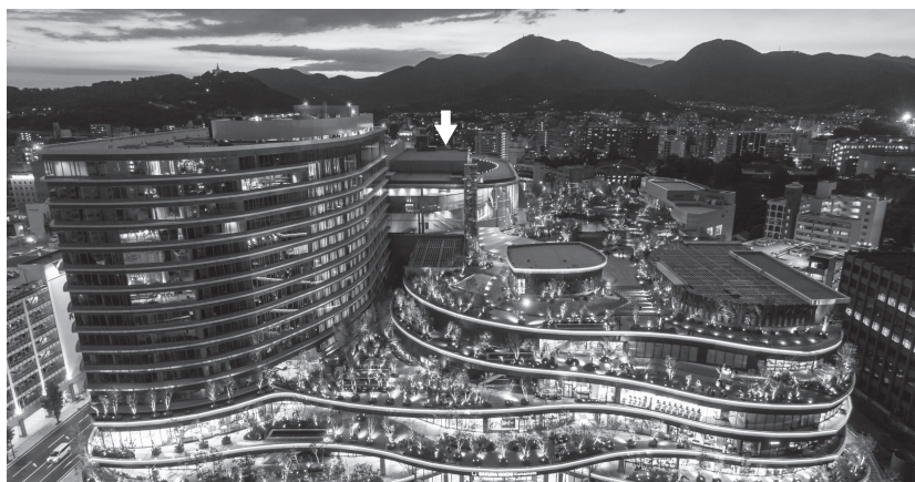
▲桜町地区市街地再開発事業の一環として整備された熊本城ホール （＝矢印／出所：熊本市ホームページ）
