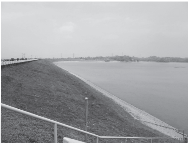
烏山頭ダムの堰堤＝台湾・台南市官田区（写真はすべて筆者撮影）
