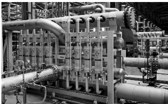
RO膜トレイン建屋 左写真の手前は動力回収装置
