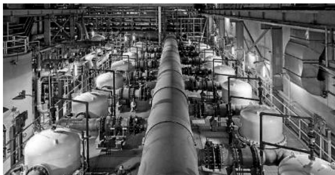
RO膜トレイン建屋 左写真の手前は動力回収装置
