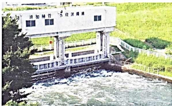
利根大堰の取水口(筆者撮影)
