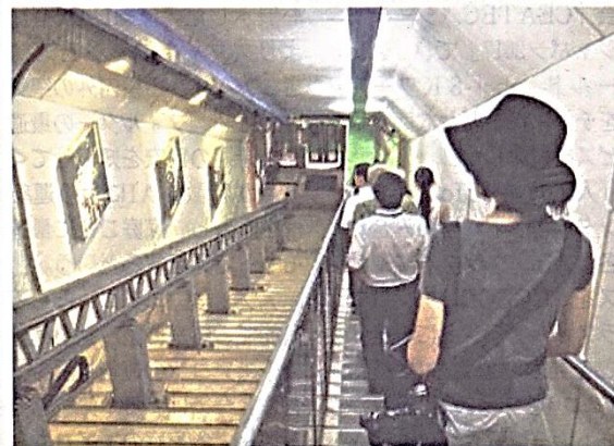
浦山ダム内部の通路
