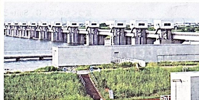
利根大堰—埼玉県行田市側(筆者撮影)
