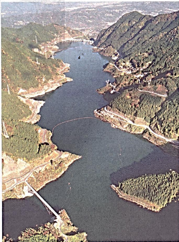
上空から見た浦山ダム（本社ヘリから）
