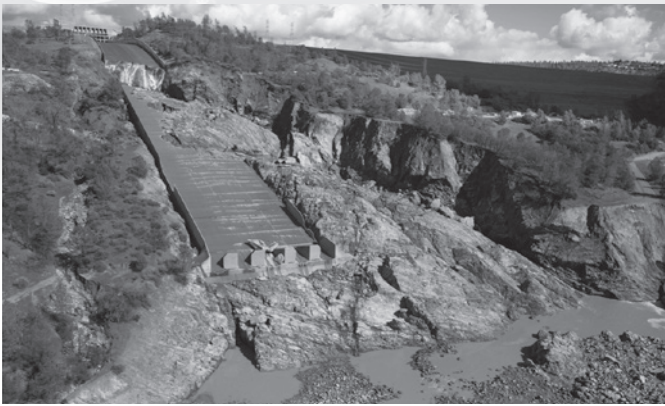
破壊された常用排水路 (2月27日撮影) 出所：California Department of Water Resources
