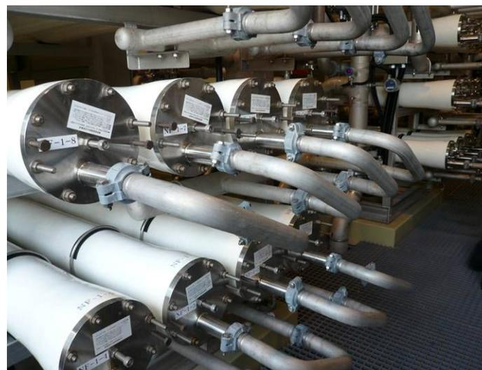
膜処理装置 (RO+NF膜)
